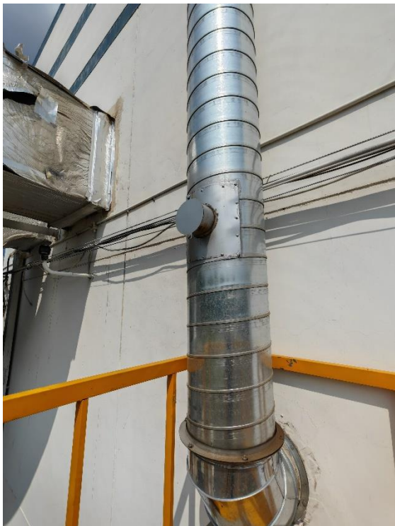
图 3-2 本项目胶膜机擦拭废气净化设施及废气排放口情况
