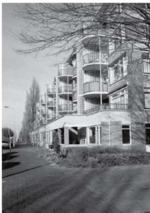
荷兰(Voorburg)住宅改造前后比较(c)改造后
