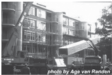
荷兰(Voorburg)住宅改造前后比较(b)改造施工中
