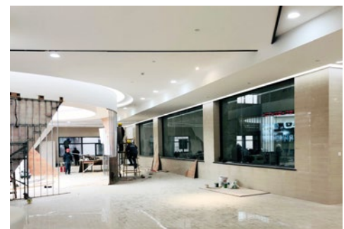
中间无框式—郑州东部环保能源工程
