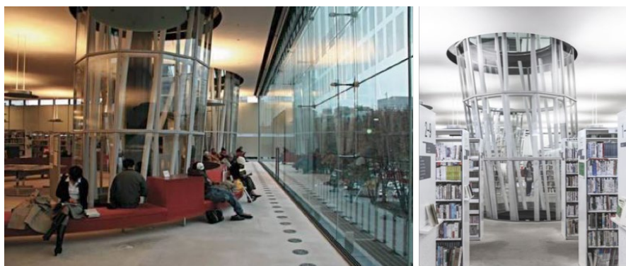
仙台媒体中心树状柱构造细节
