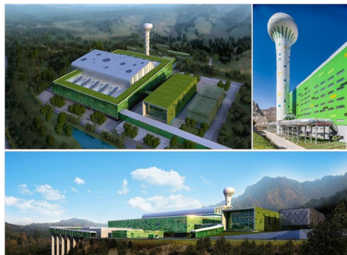
北京首钢鲁家山生物质能源项目
