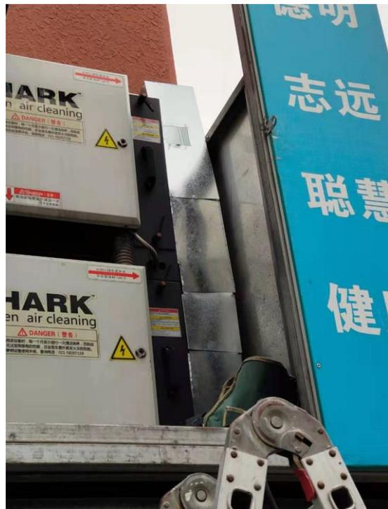
图 4-6 北京明远教育书院实验小学（知语城校区）食堂油烟净化装置及排气口照片
