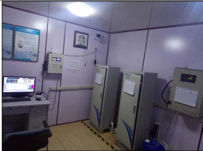
图 10 长安北京工厂现有废水在线监测仪
